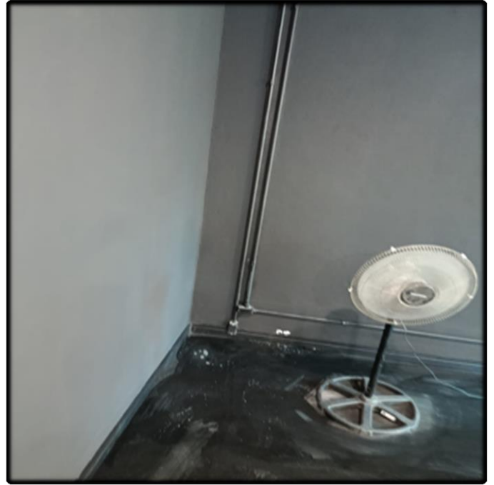
- Pintura da TV Câmara Finalizada na Cor Preta
