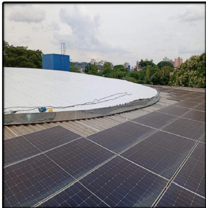
- Instalação de Calhas, Rufos e Pingadeiras
