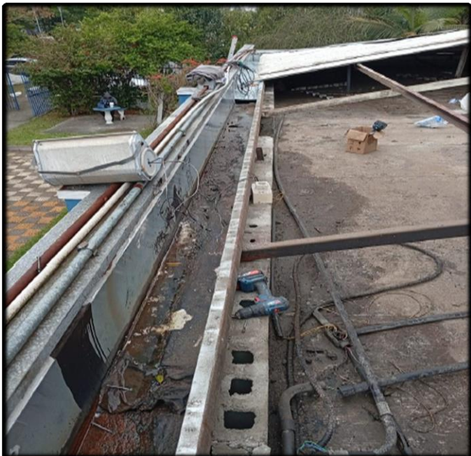
- Retirada da Calha
