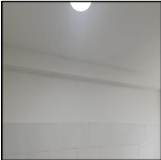
- Visão Geral da Caixa Instalada e Pintada
