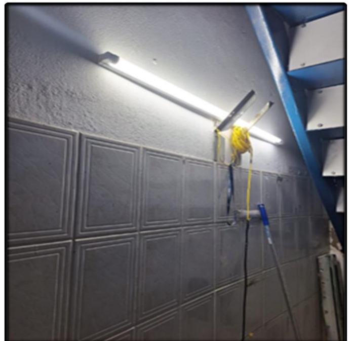
- Readequar Instalação Elétrica para Iluminação
