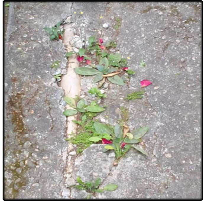
- Manutenção da Calçada (Demolição e Adequação)
