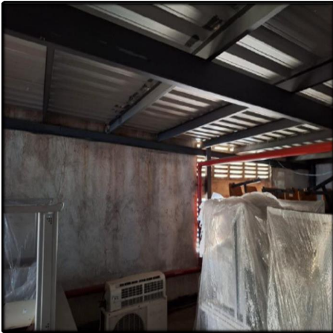
- Remoção dos Condensadores de A.C.
