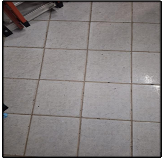
- Remoção do Piso Trincado
