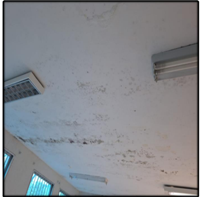
- Retirada de Mofo, Rachaduras e Infiltrações
