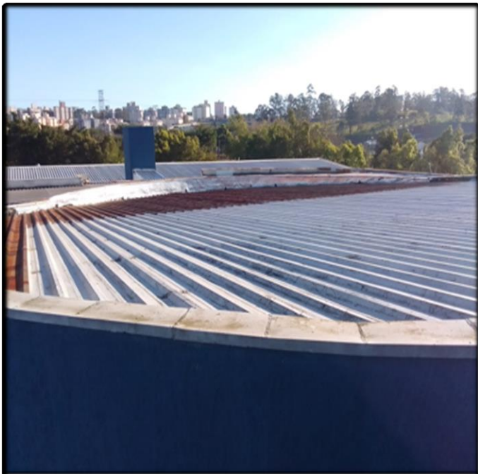
- Vista Aproximada do Telhado
