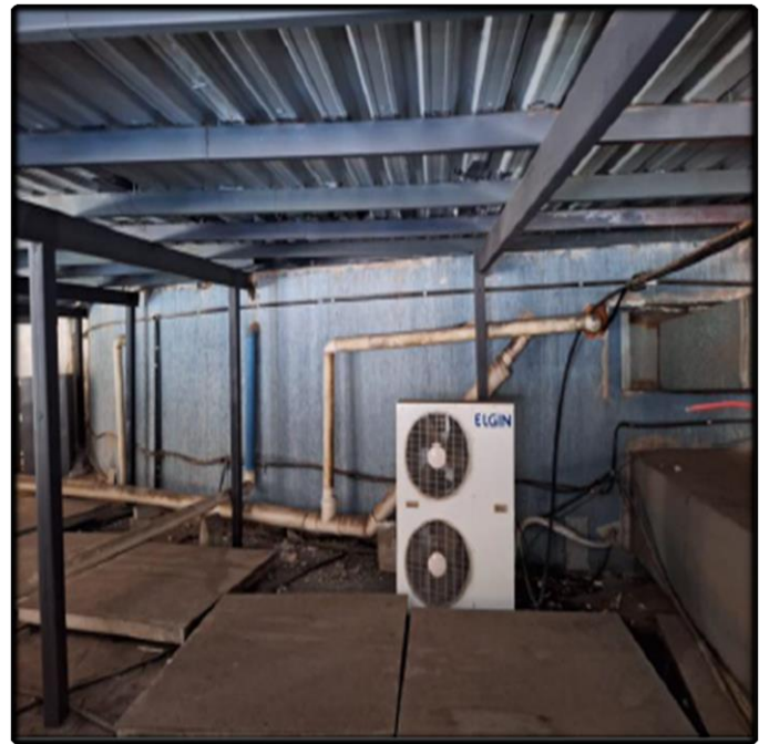
- Remoção dos Condensadores de A.C.
