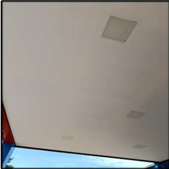
- Pintura Concluída no Teto da Marquise de Entrada
