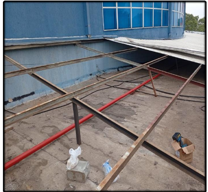
- Retirada das Telhas Metálicas
