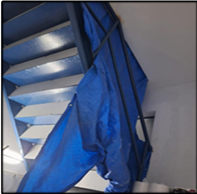
- Revestimento Lateral com Gesso (Escada)
