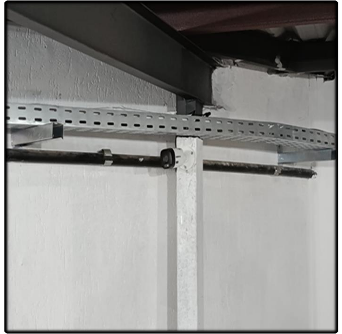
- Câmera de Segurança Instalada no Depósito Geral
