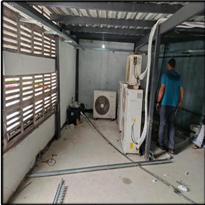
- Remanejamento dos Condensadores de A.C.
