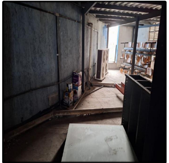
- Rede de Captação e Drenagem (Expostas)
