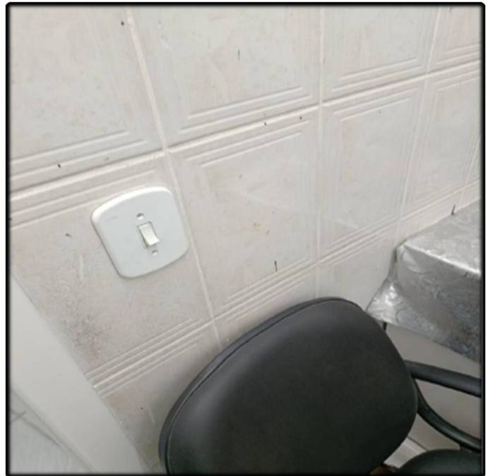
- Readequação da Instalação Elétrica (Masculino)
