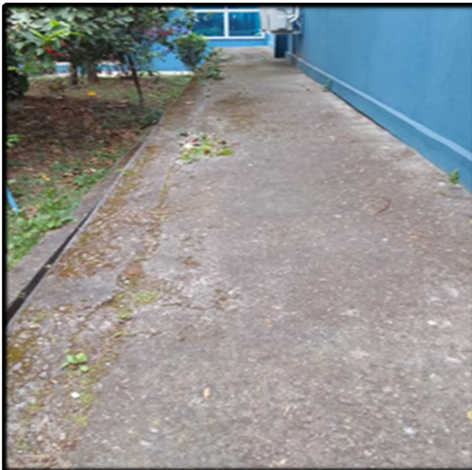
- Manutenção da Calçada (Demolição e Adequação)
