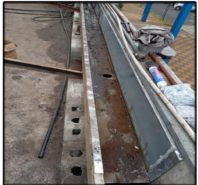
- Retirada da Calha
