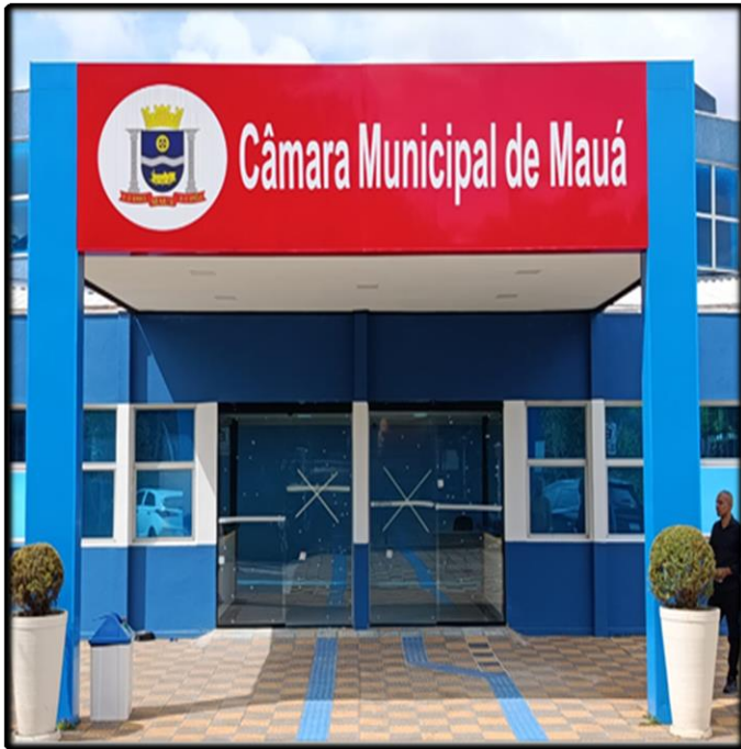
- Visão Geral da Área Externa Após a Manutenção
