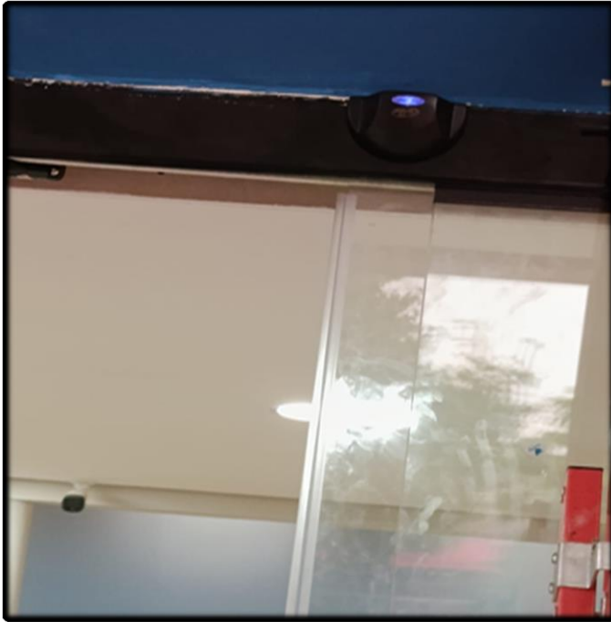
- Instalação do Sensor de Presença na Porta de Vidro
