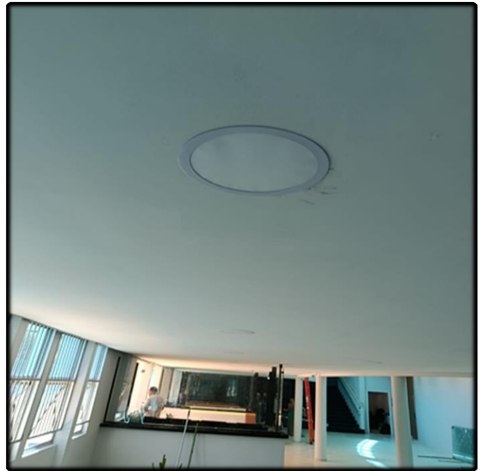
- Visão do Teto Rebaixado com Forro de Gesso
