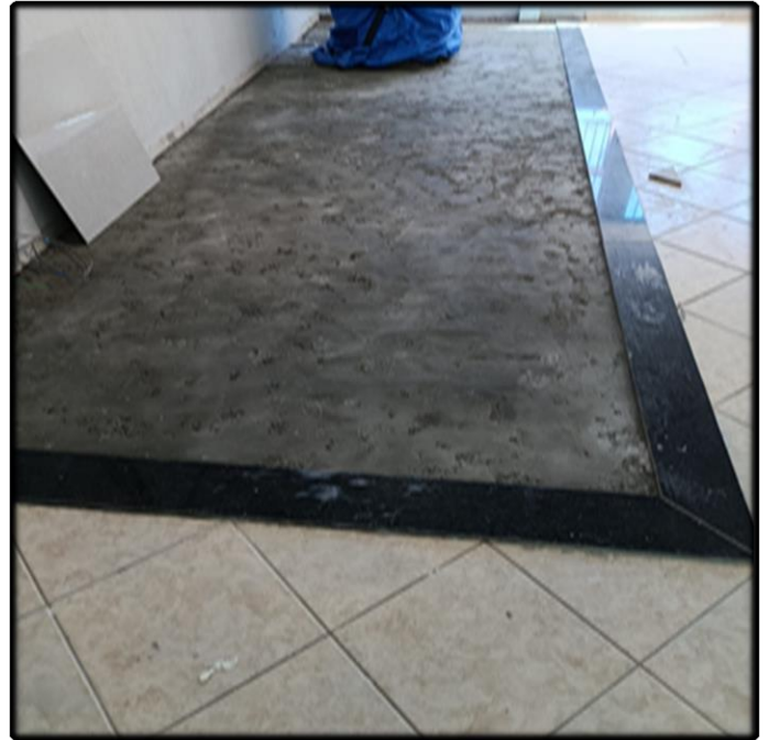
- Regularização do Contrapiso
