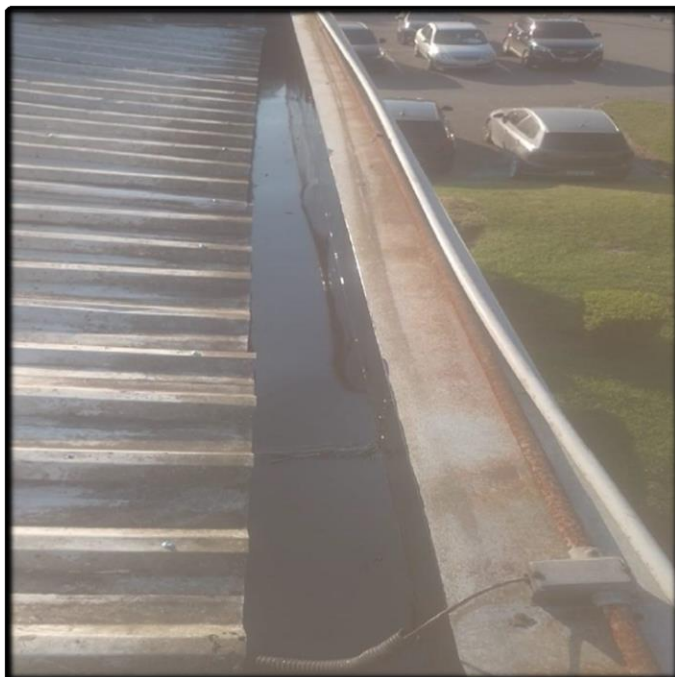
- Aplicação de Manta Asfáltica Líquida
