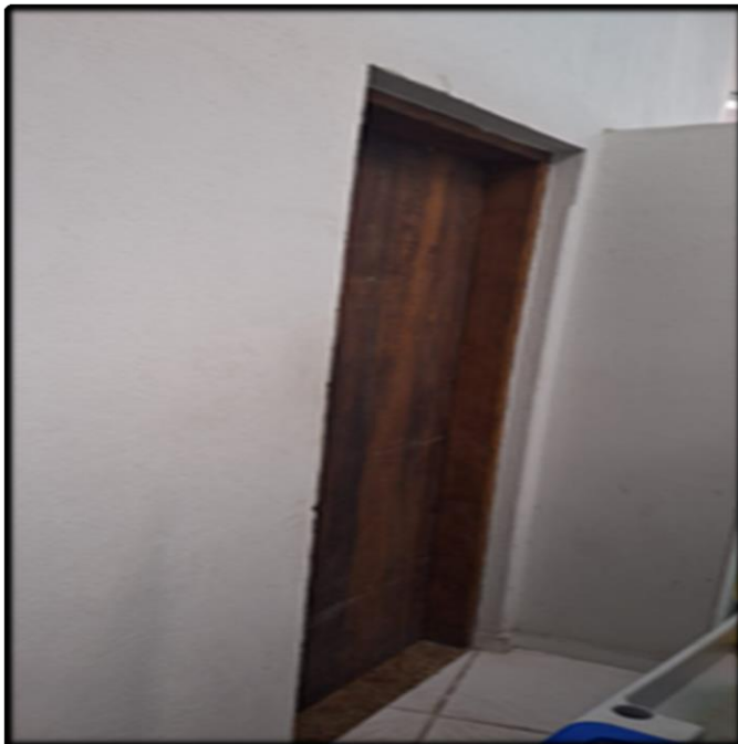
- Substituir Folha da Porta por Ventilação Permanente
