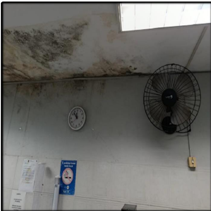
- Remoção de Manchas de Mofo
