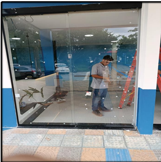
- Instalação da Porta de Vidro
