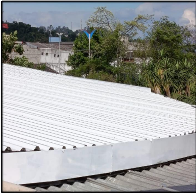
- Vista Panorâmica (Finalização dos Trabalhos)
