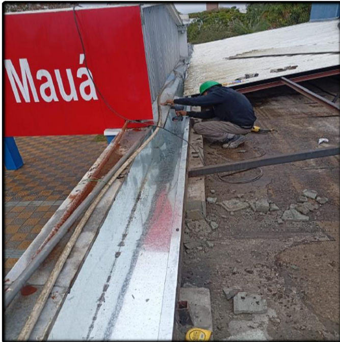
- Instalação da Nova Calha
