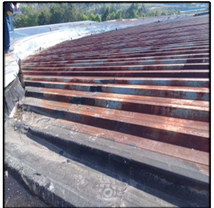
- Vista do Telhado Próximo à Calha
