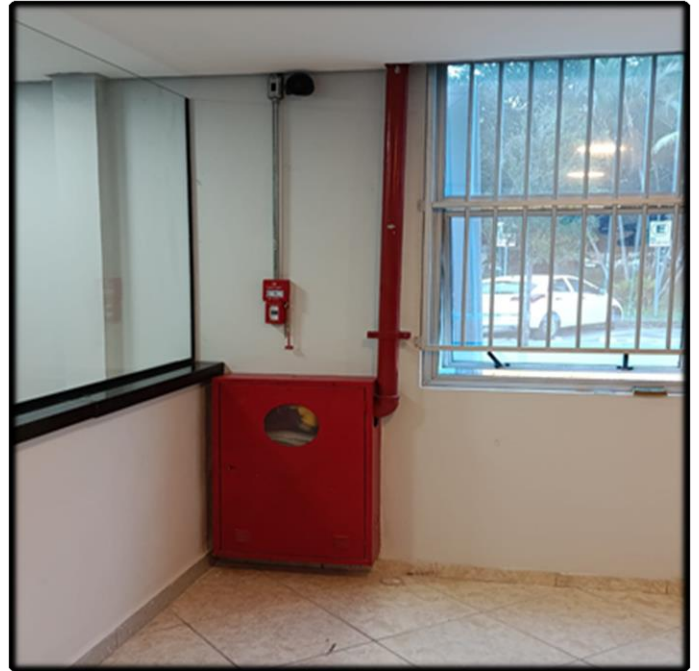
- Reposicionamento da Tubulação e Hidrante
