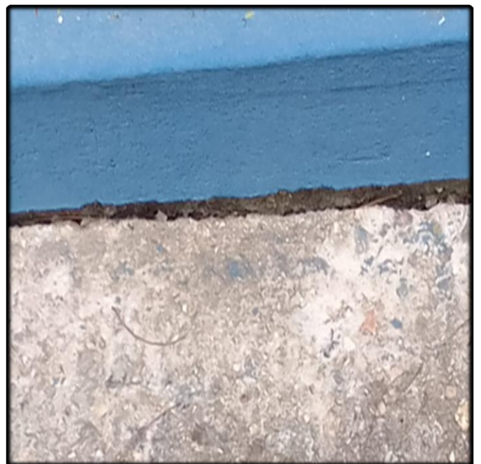
- Manutenção da Calçada (Demolição e Adequação)
