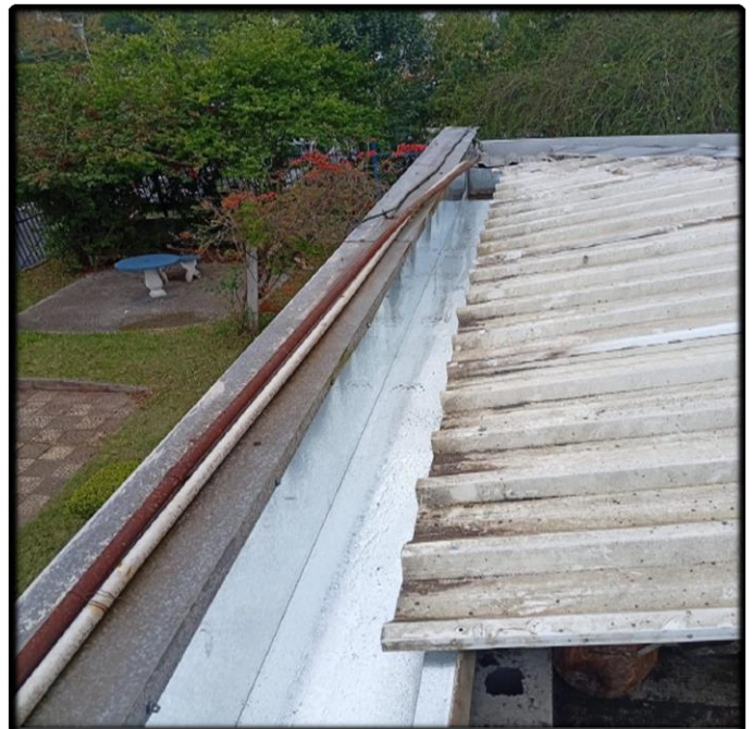
- Instalação da Nova Calha
