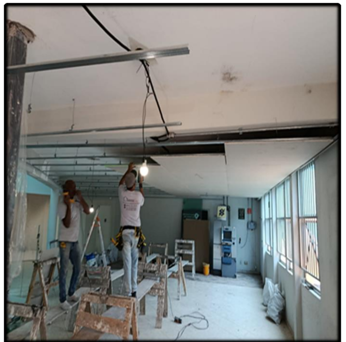
- Instalação do Teto de Gesso
