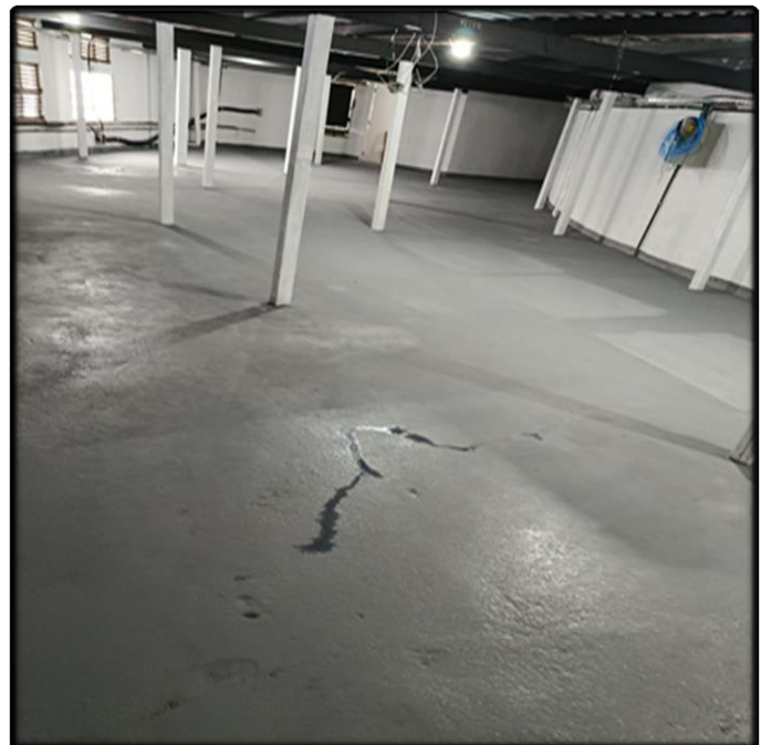
- Visão Geral da Pintura e Acabamento (Concluído)
