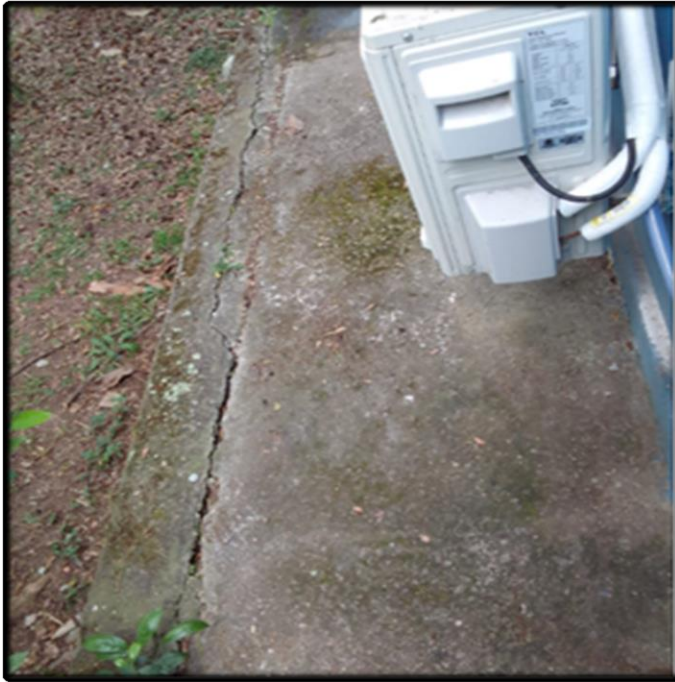
- Manutenção da Calçada (Demolição e Adequação)
