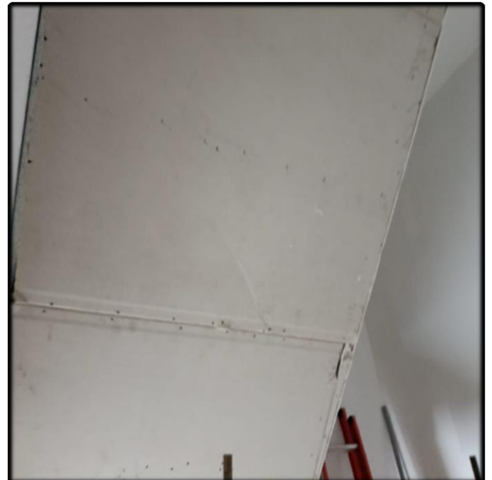
- Revestimento da Escada com Gesso (Masculino)
