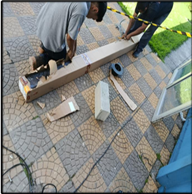
- Substituição da Porta de Entrada (Portas Automáticas)
