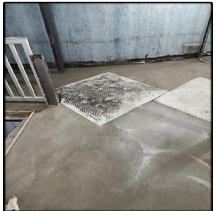
- Claraboias Fechadas com Chapa de Aço
