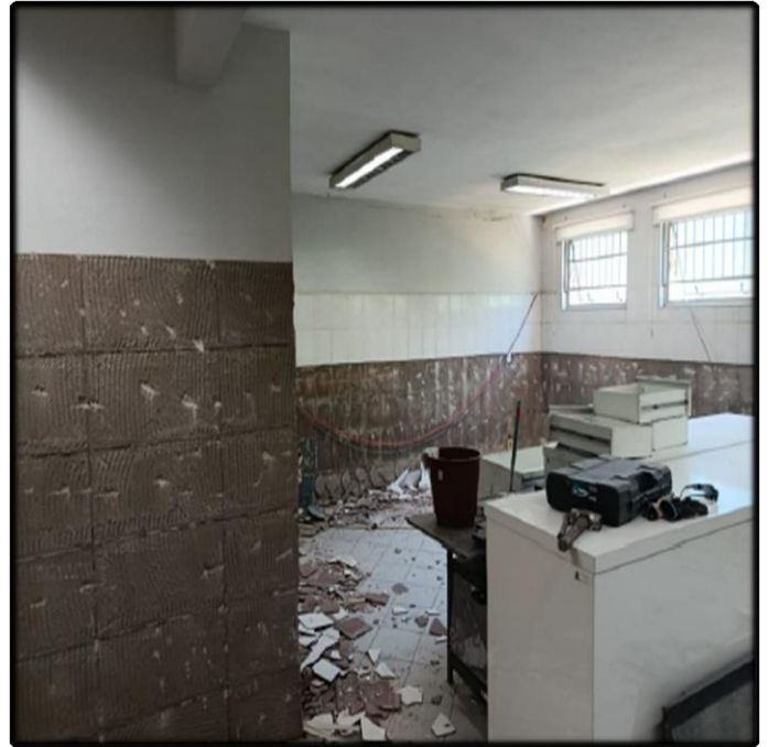
- Visão Ampla da Retirada dos Revestimentos
