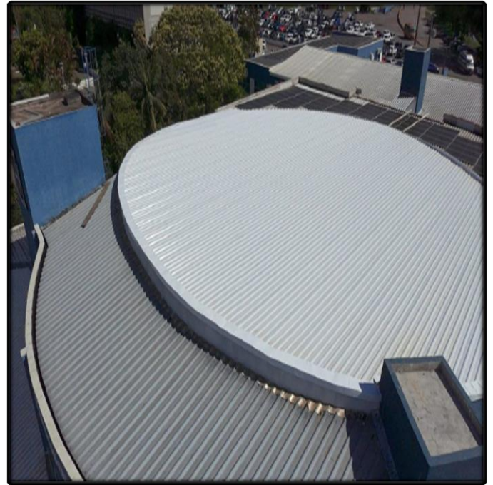
- Vista Panorâmica (Finalização dos Trabalhos)
