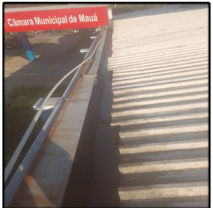
- Aplicação de Manta Asfáltica Líquida
