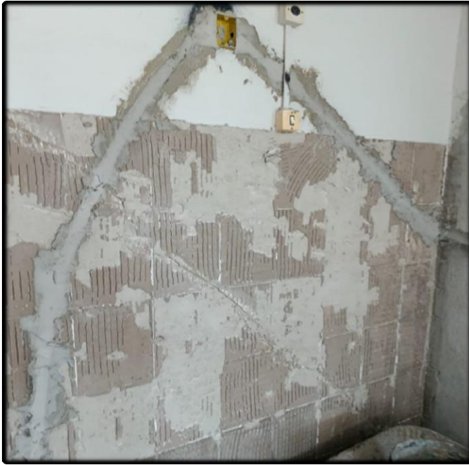
- Registro da Retirada de Eletrodutos e Canaletas
