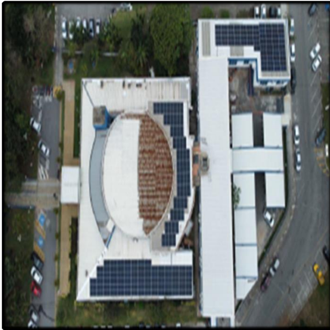
- Vista Panorâmica do Telhado
