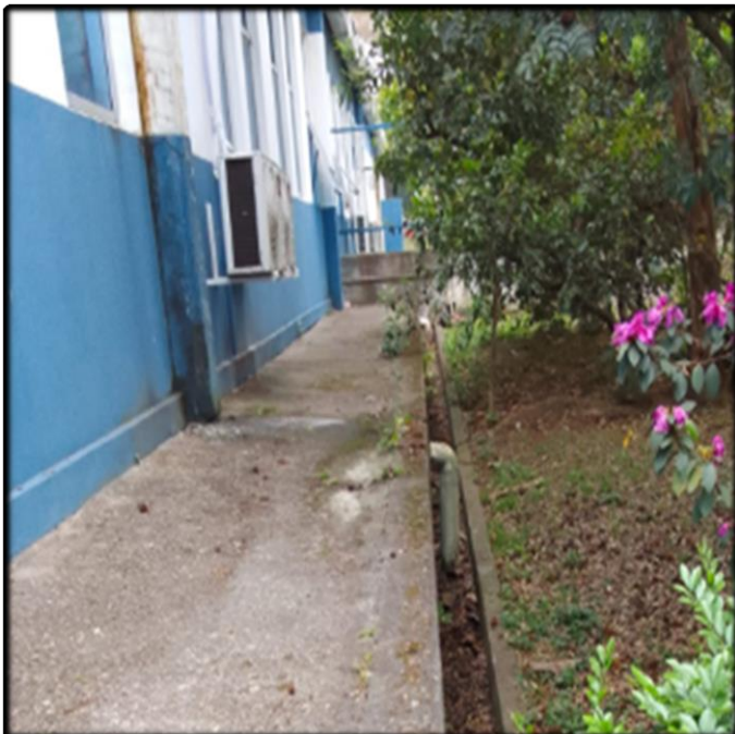
- Manutenção da Calçada (Demolição e Adequação)
