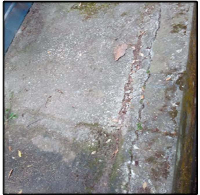
- Manutenção da Calçada (Demolição e Adequação)
