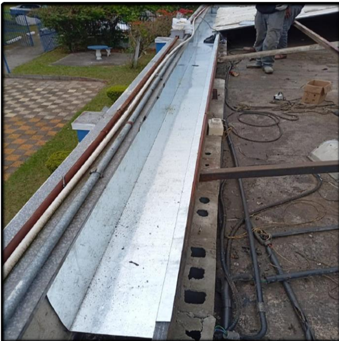
- Instalação da Nova Calha
