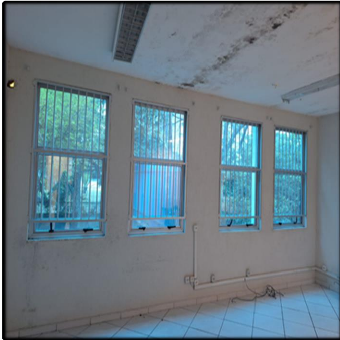
- Retirada de Mofo, Rachaduras e Infiltrações
