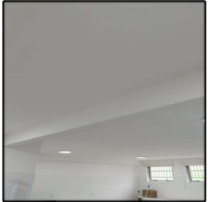
- Pintura Concluída no Teto da Copa Legislativa
