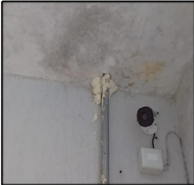
- Goteira (Caixa Eletrônico)
