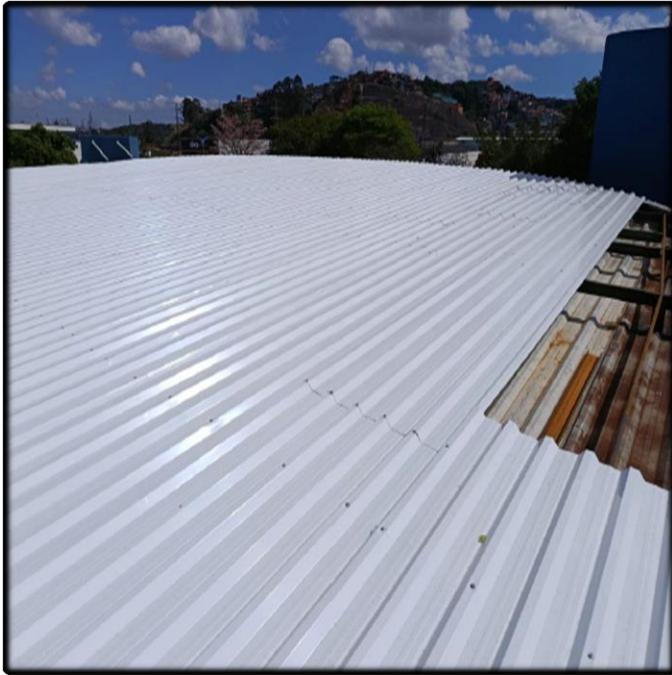
- Instalação das Telhas Metálicas
