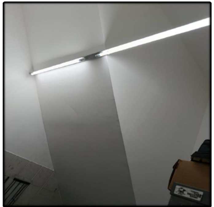
- Revestimento da Escada com Gesso (Masculino)
