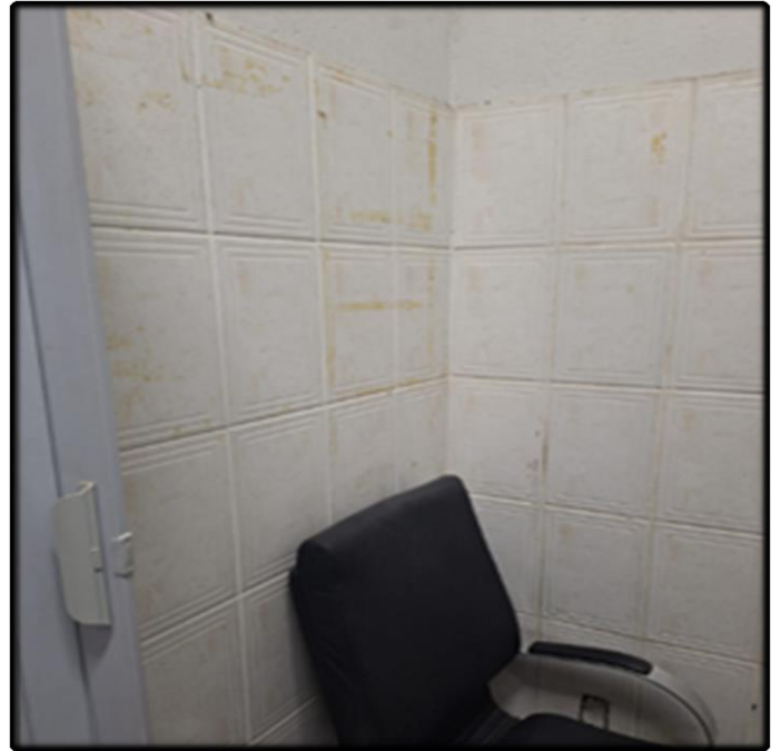
- Remoção do Revestimento Trincado (Feminino)
