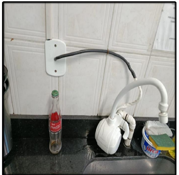
- Readequação da Rede Elétrica
