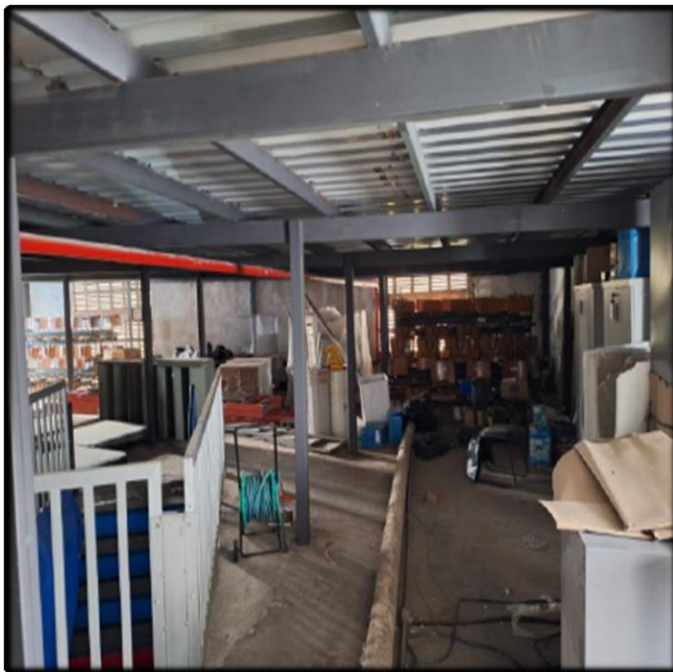
- Remoção dos Condensadores de A.C.
