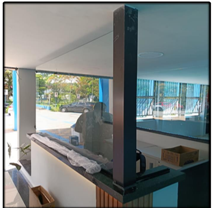
- Coluna de Aço Instalada na Estrutura da Guarita
