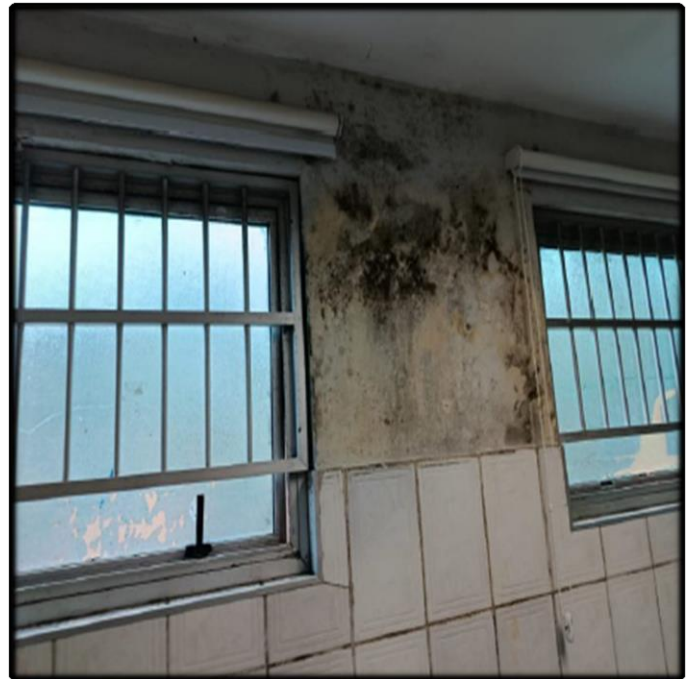
- Remoção de Manchas de Mofo
