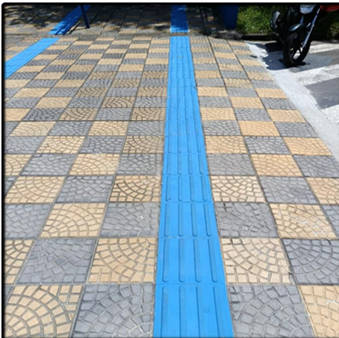
- Piso Tátil com Acabamento e Acessibilidade Adequada
