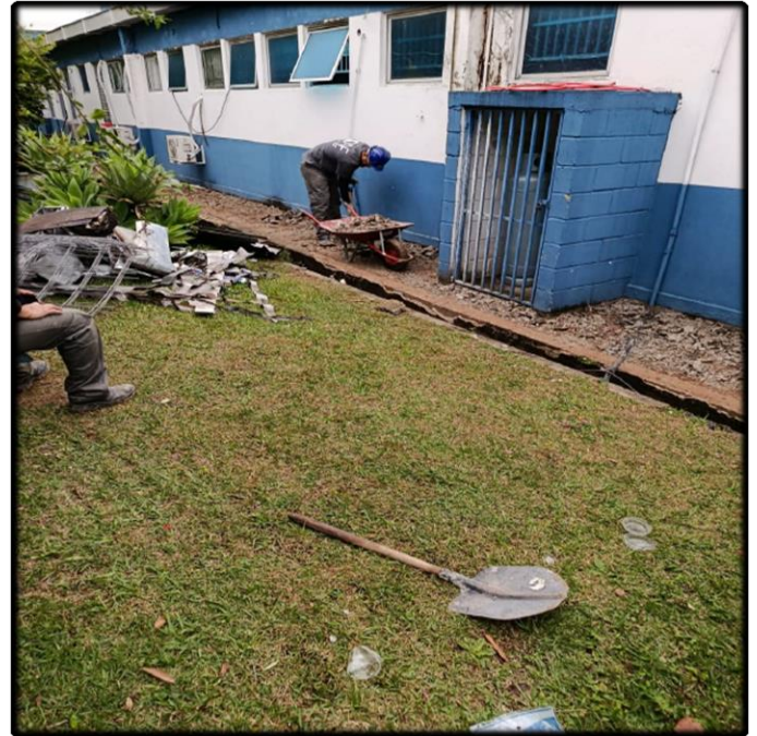
- Demolição da Calçada e Remoção do Entulho
