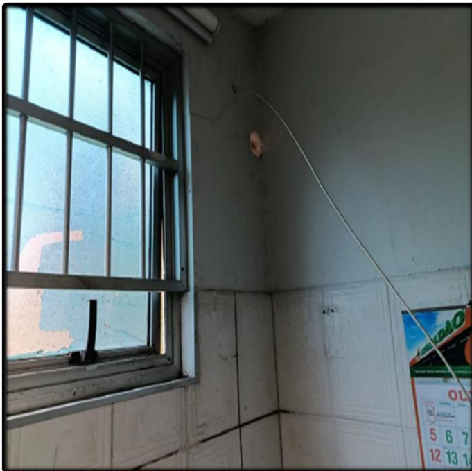
- Furos na Parede
