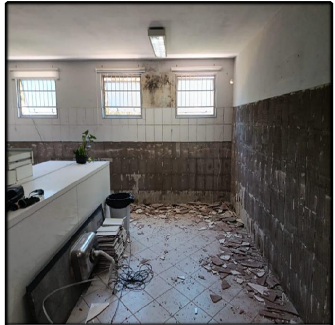
- Limpeza Pós Adequação Conforme Normas Técnicas
