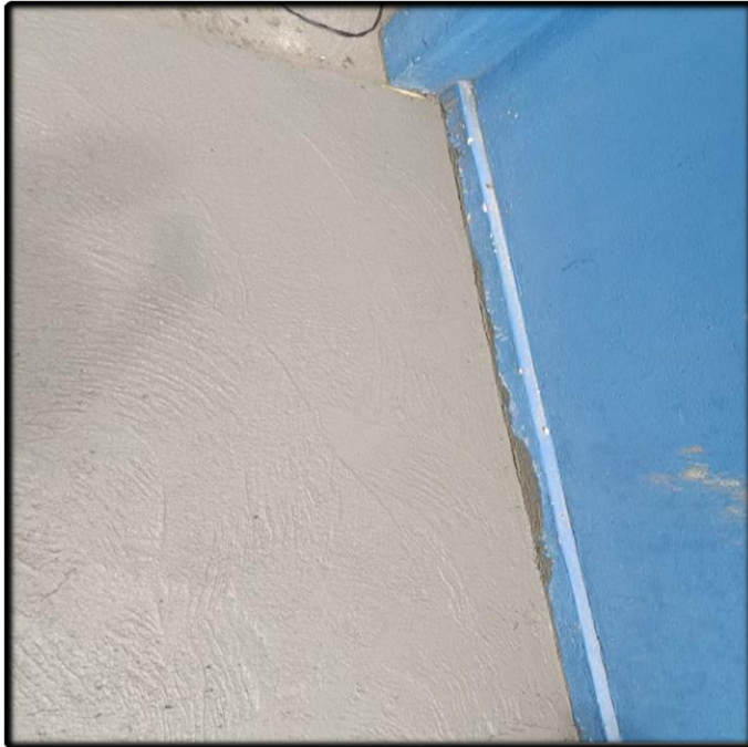
- Nivelamento da Nova Calçada
