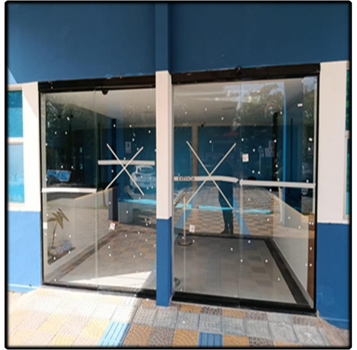
- Vista Geral da Porta de Entrada - Automatizada
