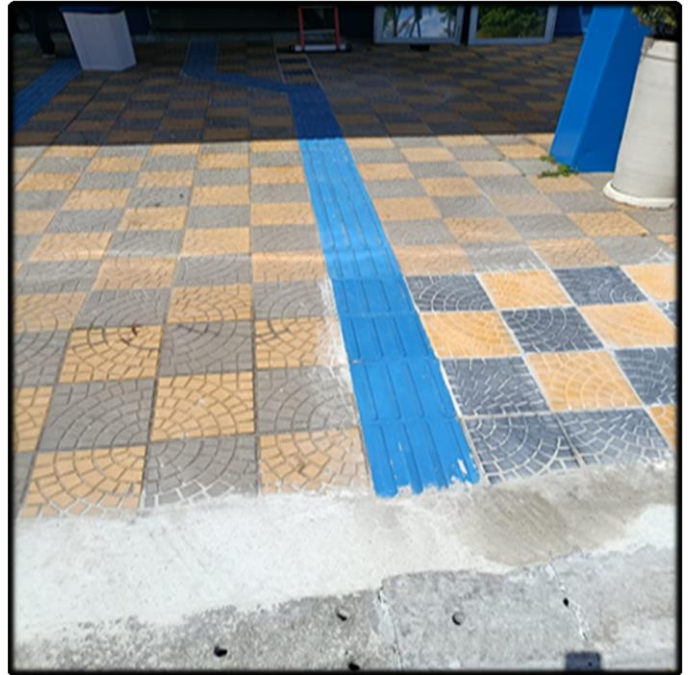
- Piso Tátil Pintado e Reposicionado na Porta de Vidro
