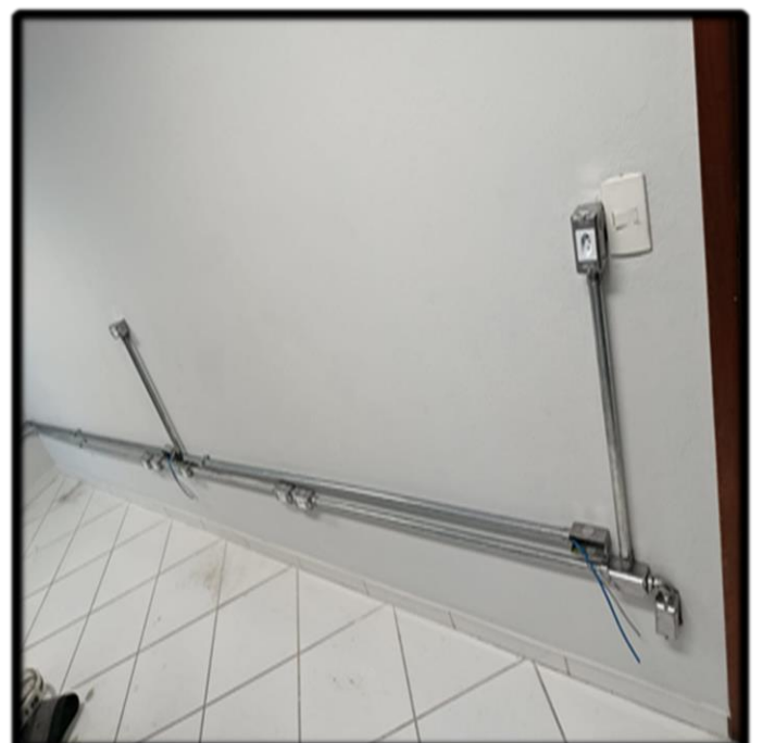
- Instalação de Eletrodutos (Elétrica, Dados e Voz)
