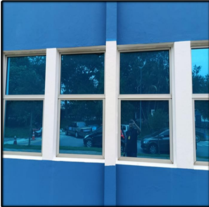
- Vista Externa das Janelas Devidamente Fechadas
