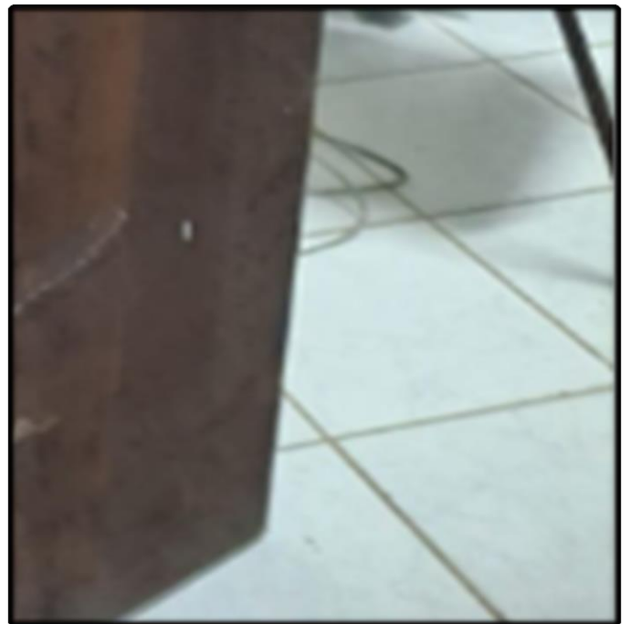
- Remoção do Piso Trincado (Feminino)
