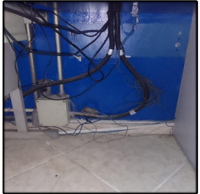
- Visão Geral da Estrutura Antes das Novas Instalações
