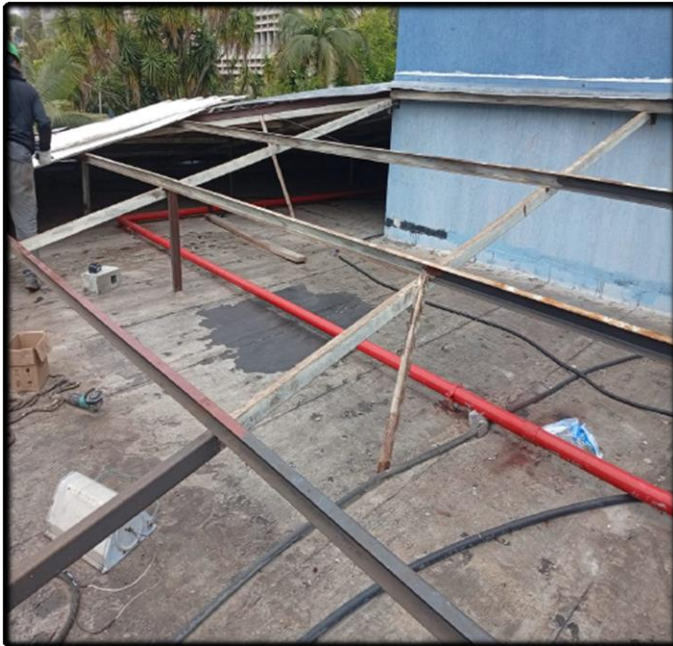
- Retirada das Telhas Metálicas
