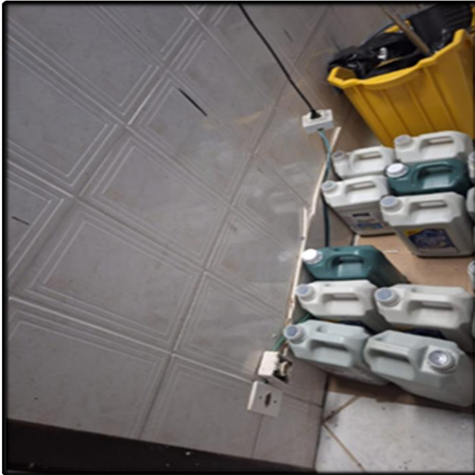
- Readequar Instalação Elétrica para Iluminação
