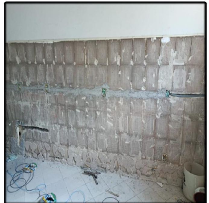
- Novos Pontos de Tomadas e Esgoto para a Pia
