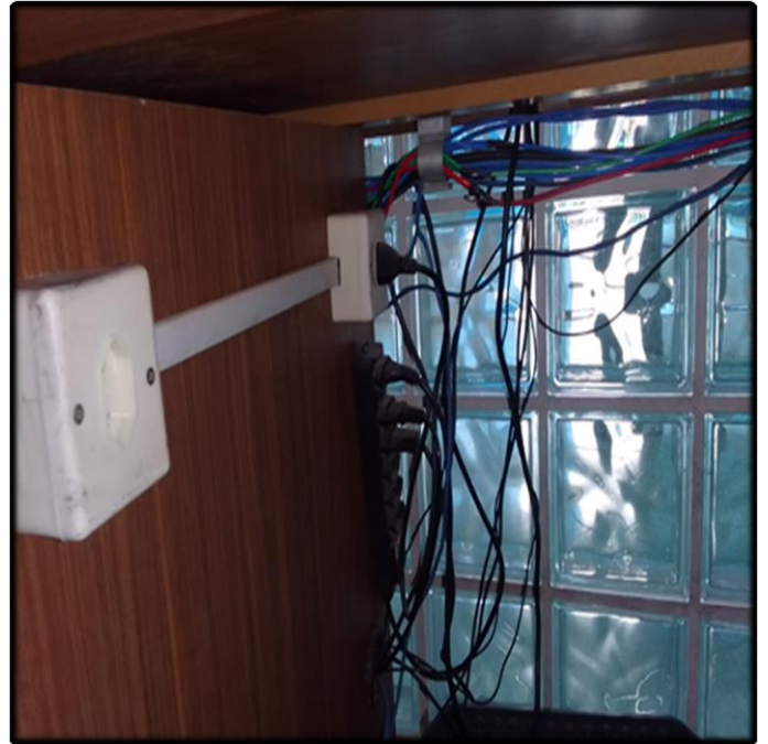
- Imagem da Entrada da Câmara Antes da Adequação
