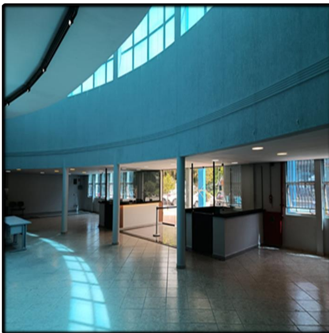
- Visão Geral da Parte Interna da Recepção Concluída
