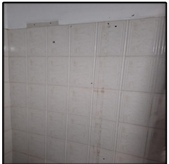
- Remoção do Revestimento Trincado
