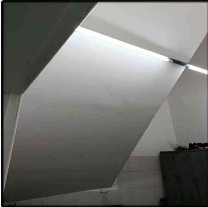
- Revestimento da Escada com Gesso (Masculino)
