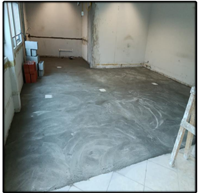
- Regularização do Contrapiso para o Futuro Estúdio
