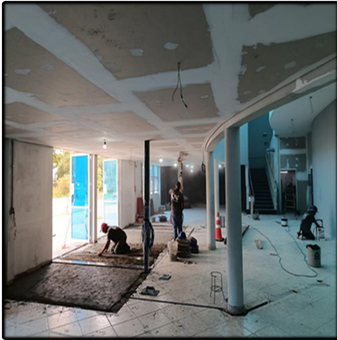
- Forro de Gesso Concluído para Receber Pintura
