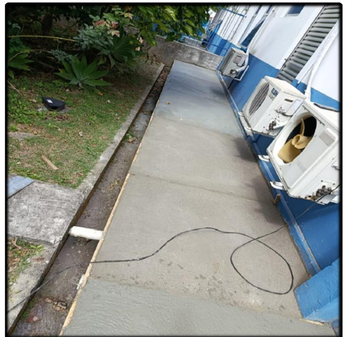
- Calçada e Canaleta (Finalizado)
