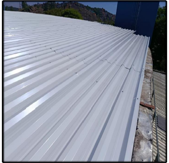
- Instalação das Telhas Metálicas
