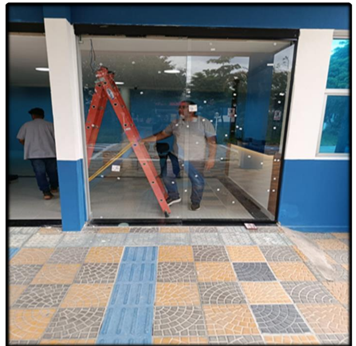
- Instalação da Porta de Vidro
