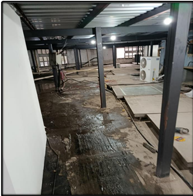
- Remanejamento da Rede de Captação de Águas
