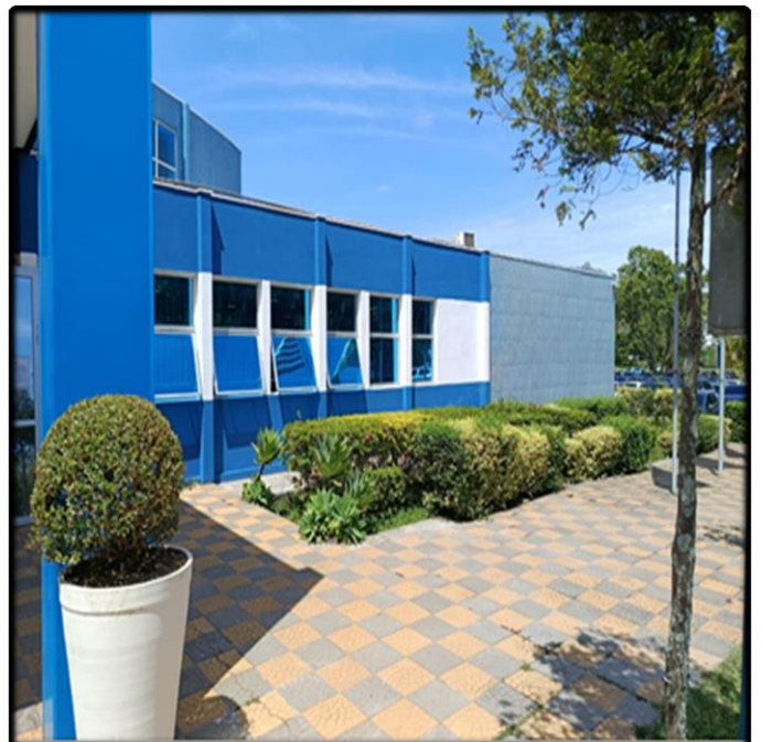
- Pintura Finalizada nas Paredes Externas
