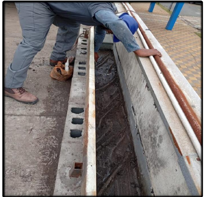
- Instalação da Nova Calha
