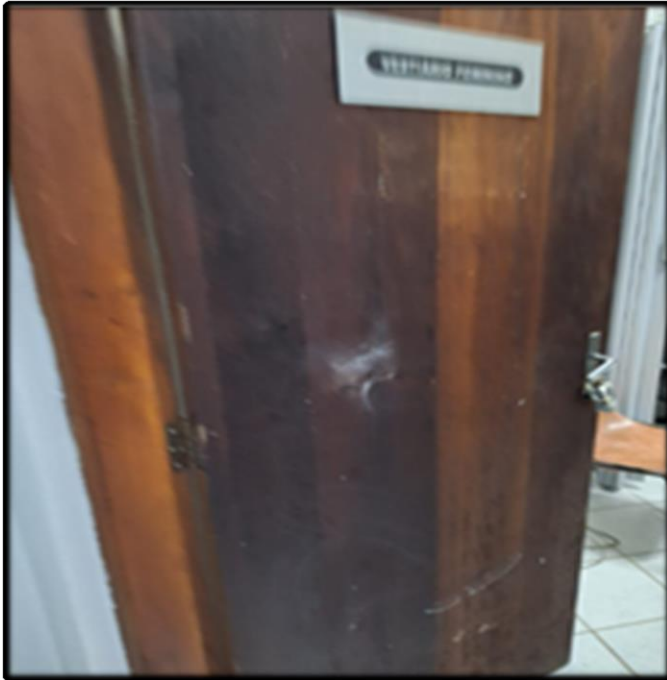
- Substituir Porta por Ventilação Permanente (Feminino)
