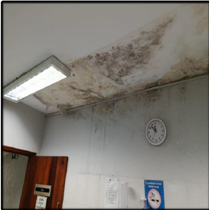
- Remoção de Manchas de Mofo
