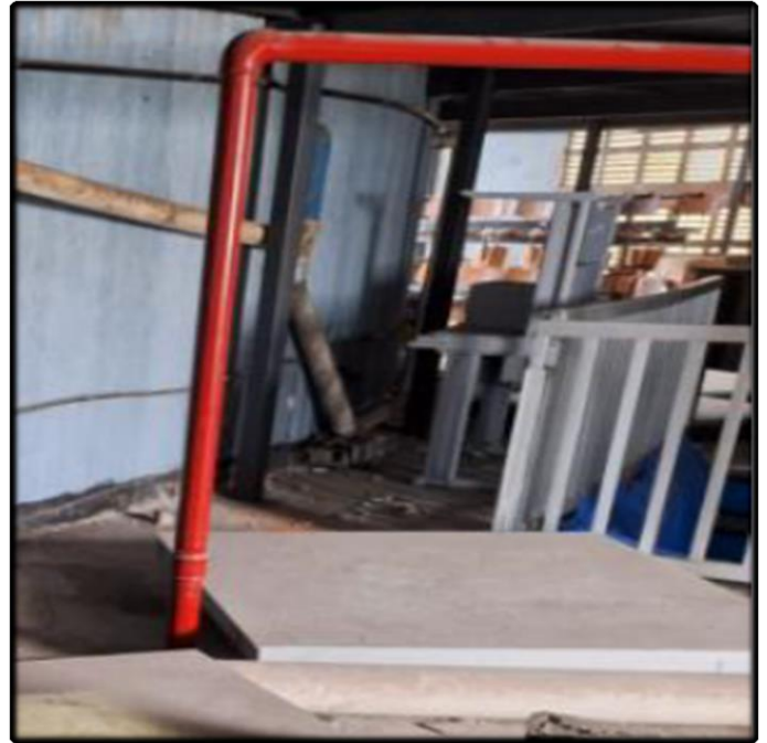
- Instalação da Rede de Incêndio (AVCB)
