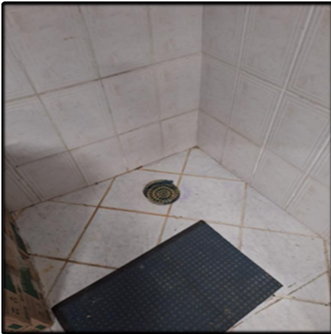
- Remoção do Revestimento Trincado
