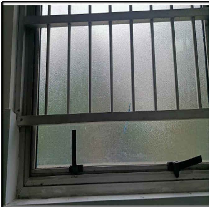
- Janela com Caixilho e Grade de Alumínio Reforçada
