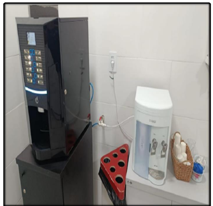
- Pontos de Água para o Purificador e Máquina de Café
