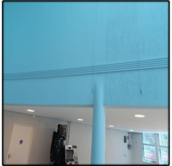
- Acabamento de Gesso Aplicado na Parede Interna
