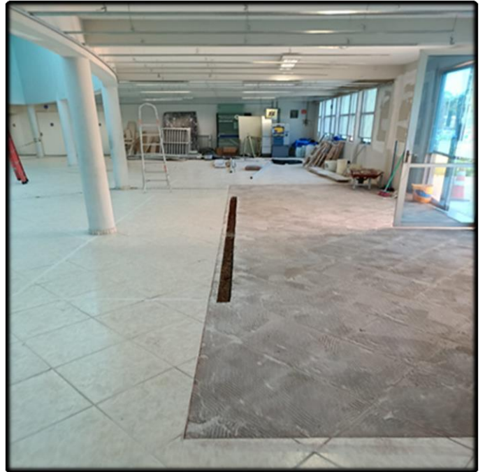
- Abertura no Piso para o Sistema de Catracas
