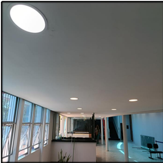
- Sistema de Iluminação Embutido (Lâmpadas LED)
