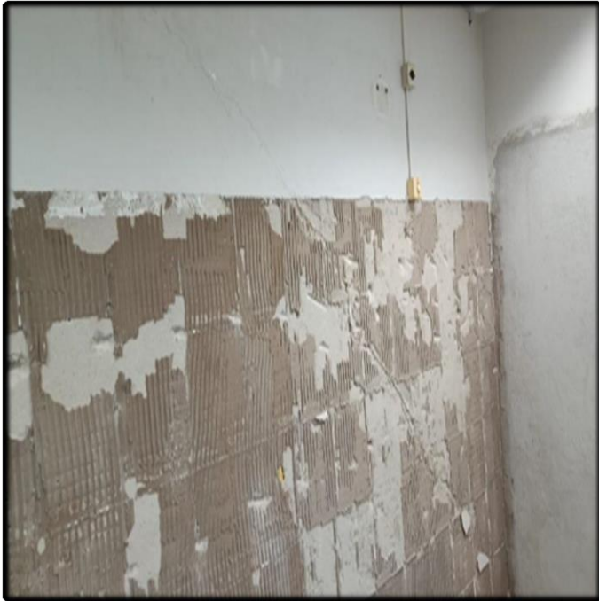
- Processo de Retirada dos Revestimentos
