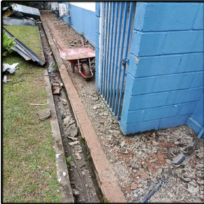
- Demolição da Calçada e Remoção do Entulho
