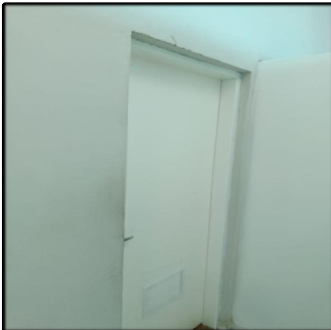
- Porta com Ventilação Permanente (Masculino)
