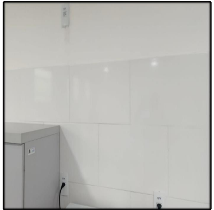
- Novos Pontos de Energia com o Devido Acabamento
