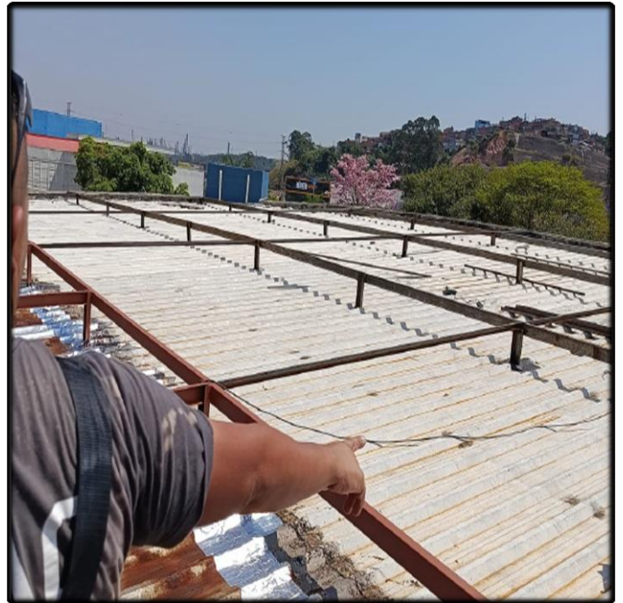
- Início da Troca de Telhas
