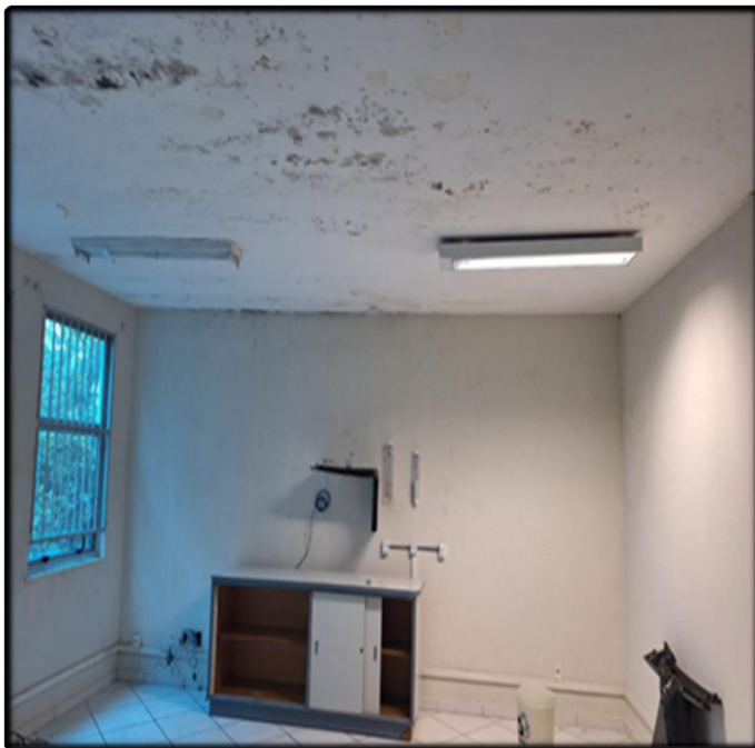
- Retirada de Mofo, Rachaduras e Infiltrações
