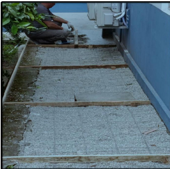
- Nivelamento e Compactação
