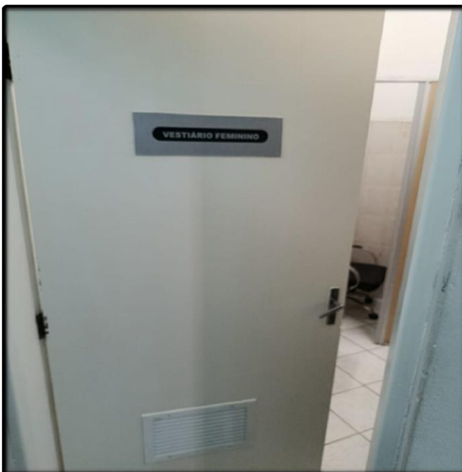
- Porta com Ventilação Permanente (Feminino)
