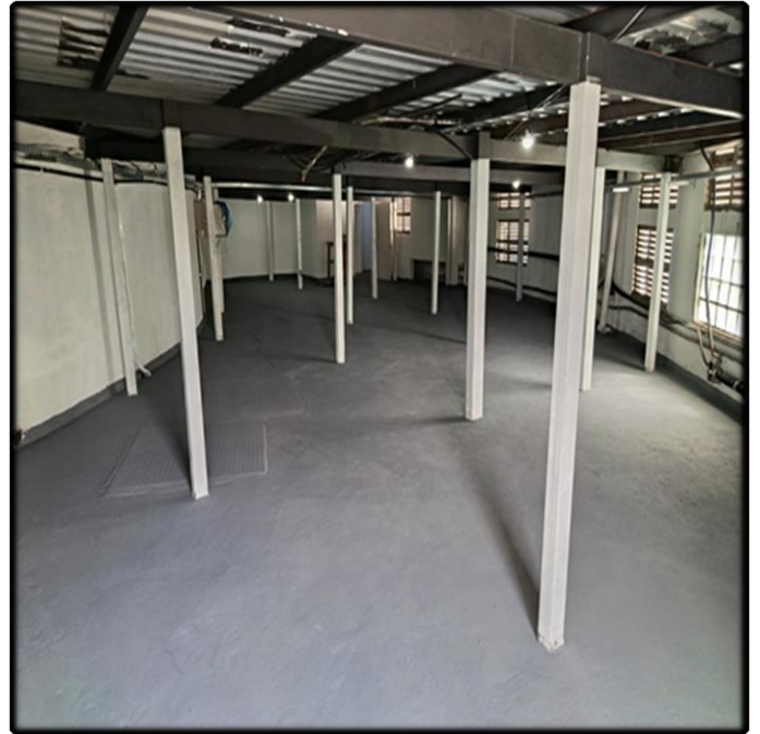
- Nivelamento de Piso Concluído
