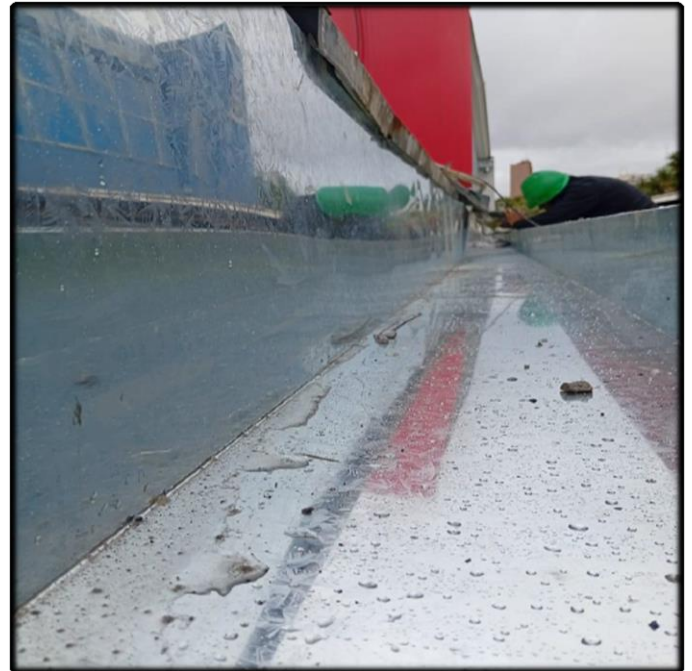
- Instalação da Nova Calha
