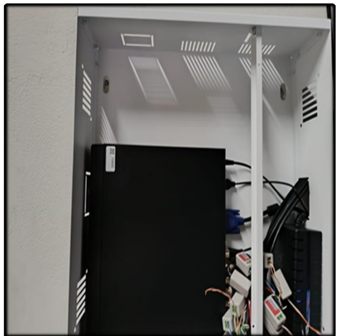
- Fixação do Novo Aparelho de DVR no Data Center
