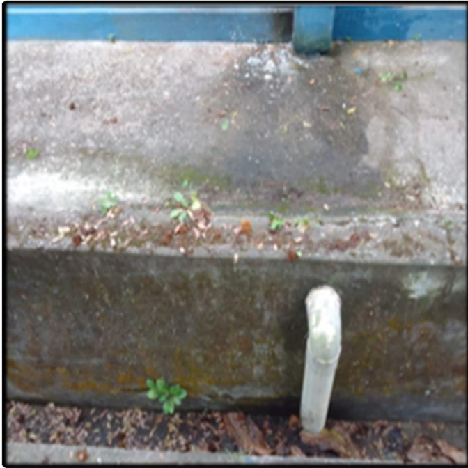
- Manutenção da Calçada (Demolição e Adequação)
