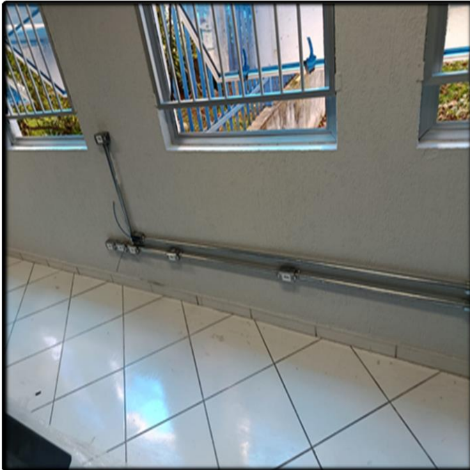
- Instalação de Eletrodutos (Elétrica, Dados e Voz)
