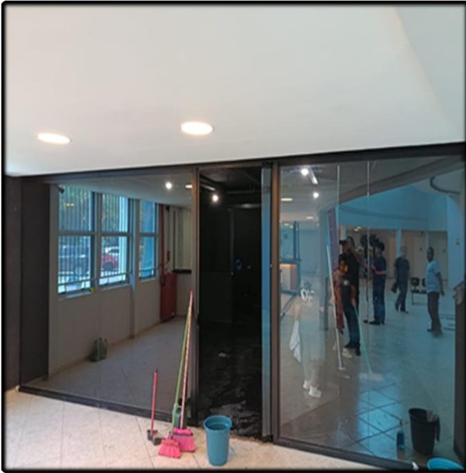
- Nova Estrutura Projetada para a Futura TV Câmara
