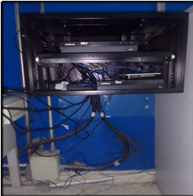
- Visão Geral da Estrutura Antes das Novas Instalações
