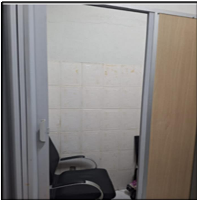
- Remoção do Revestimento Trincado (Feminino)
