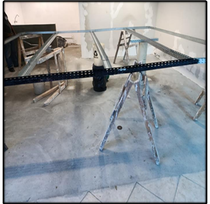
- Preparação da Eletrocalha para Elétrica e Iluminação
