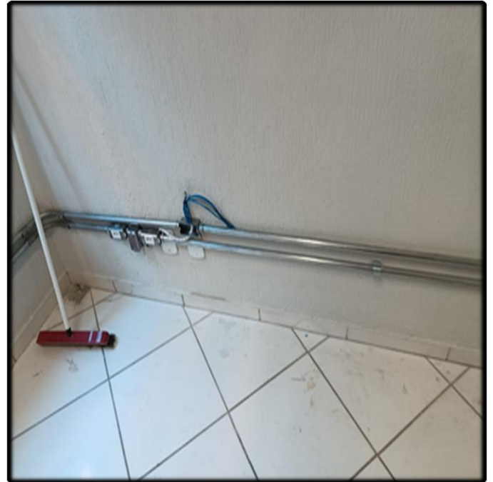
- Instalação de Eletrodutos (Elétrica, Dados e Voz)
