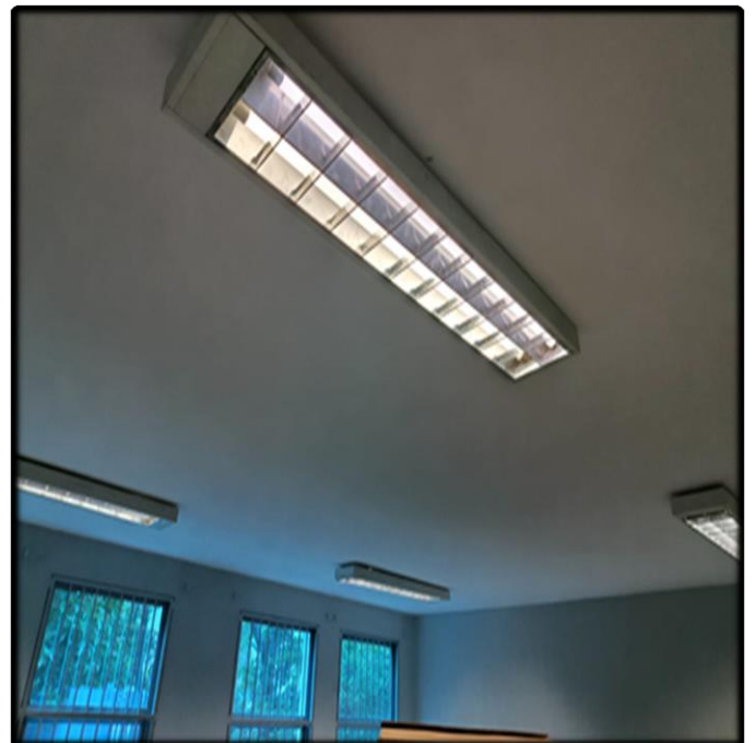
- Sistema de Iluminação (Finalizado)
