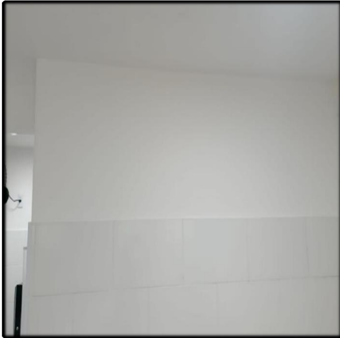
- Remoção do Marcas de Bolor e Nova Pintura
