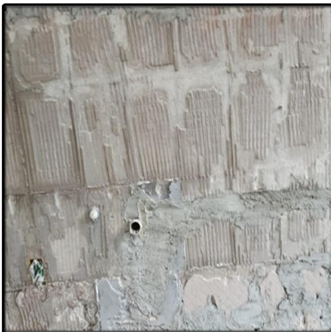
- Criação de Ponto de Água para a Torneira Elétrica
