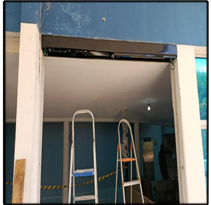
- Instalação do Motor no Porta de Vidro
