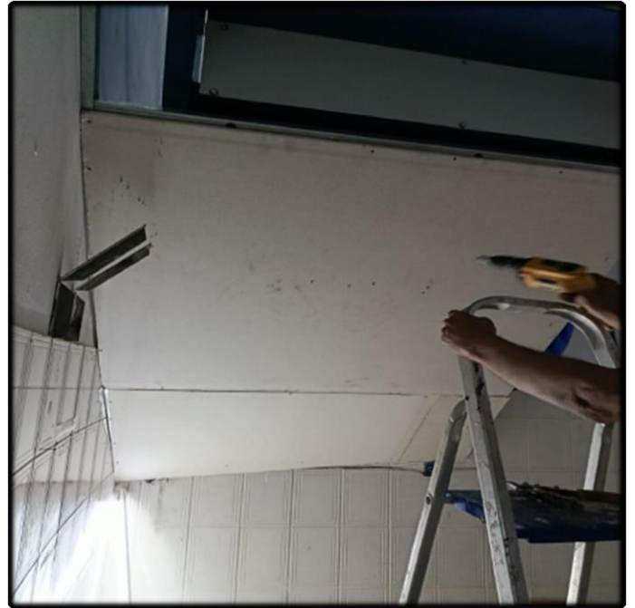
- Revestimento da Escada com Gesso (Masculino)
