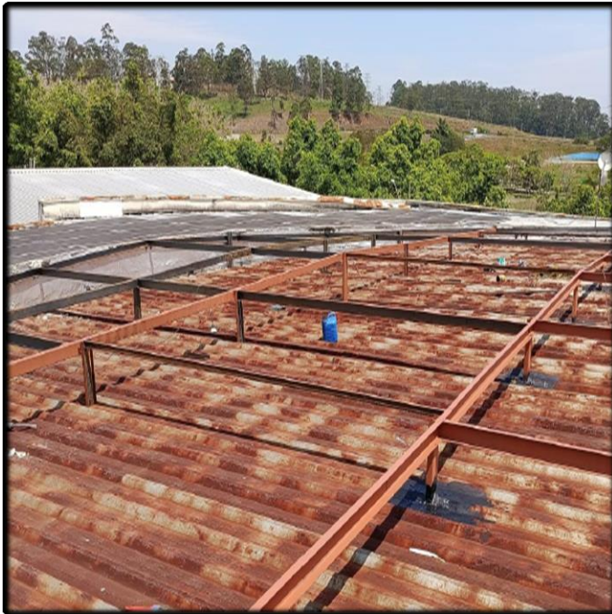
- Início da Troca de Telhas
