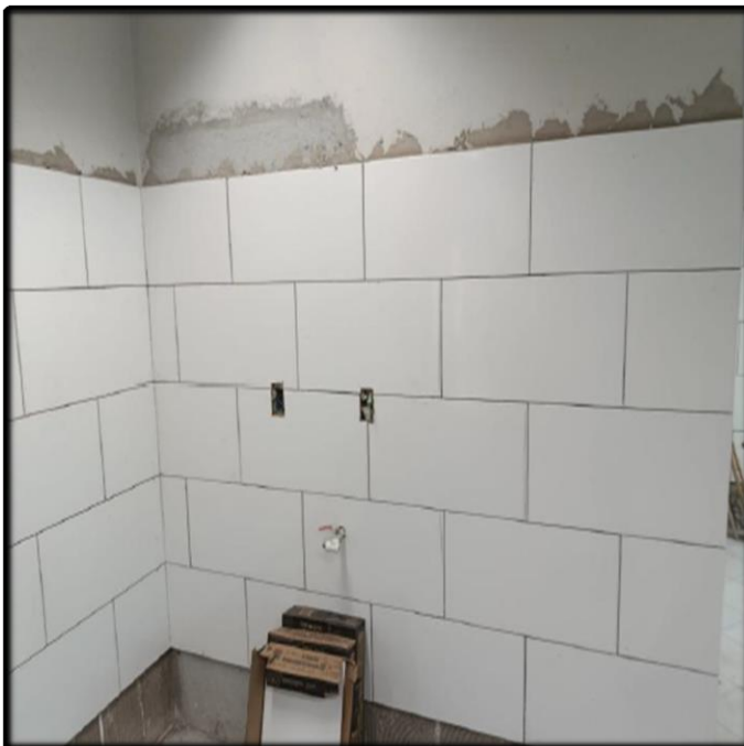
- Instalação de Novos Azulejos (Alinhamento em Destaque)
