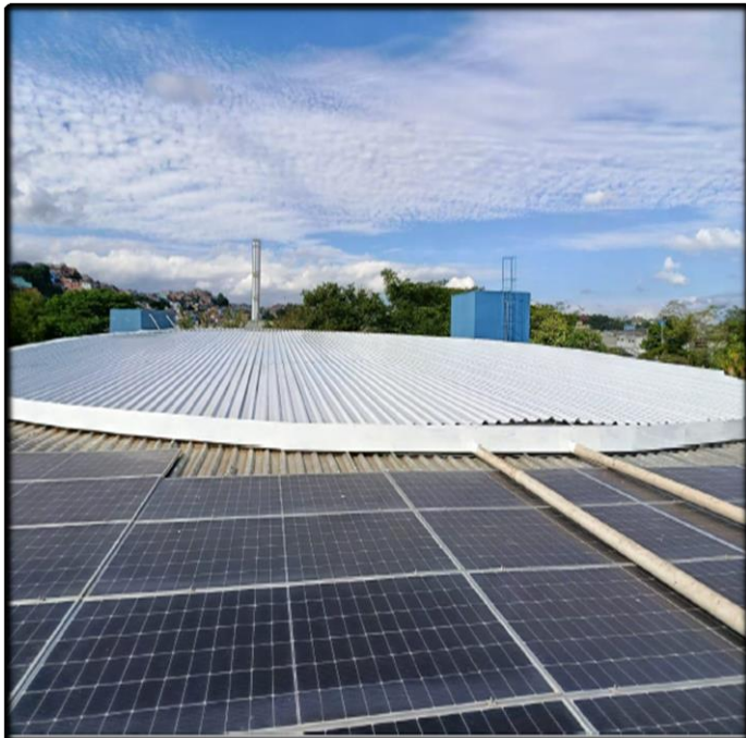
- Vista Panorâmica (Finalização dos Trabalhos)
