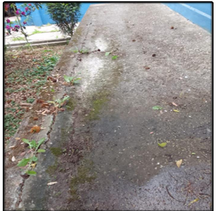
- Manutenção da Calçada (Demolição e Adequação)
