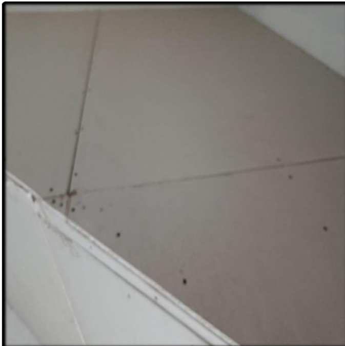
- Revestimento da Escada com Gesso (Masculino)
