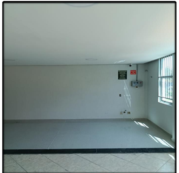
- Espaço Reestruturado com Ponto de Água e Elétrica
