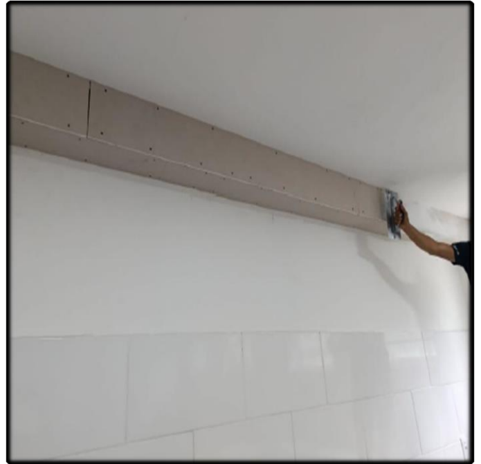
- Instalação da Caixa para o Ar Condicionado
