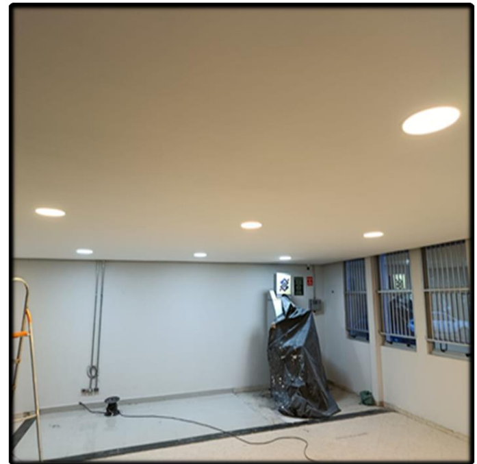
- Visão Geral da Iluminação Embutida
