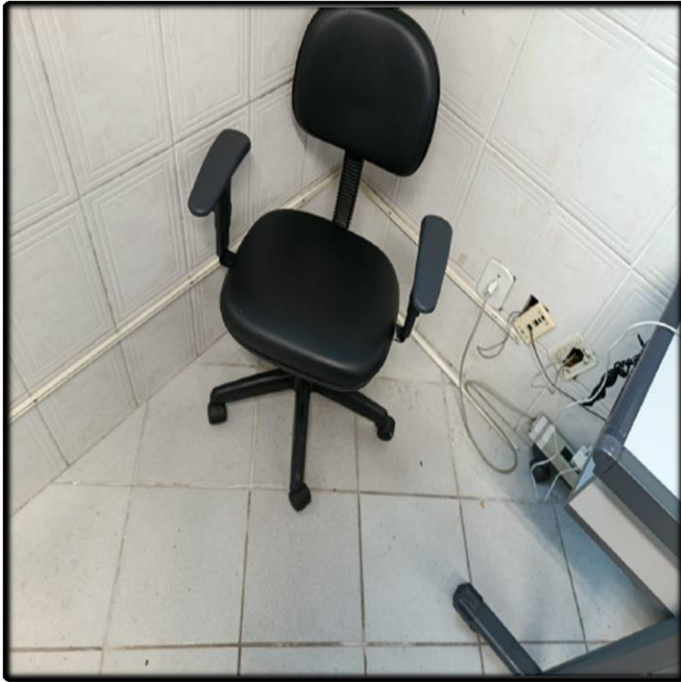
- Readequação da Rede Elétrica
